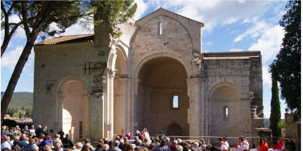
Restes de l'edifici de Santa Maria de Besalú.
