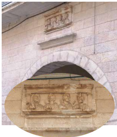
Relleu dels Quatre Sants Màrtirs a la plaça del Vi
